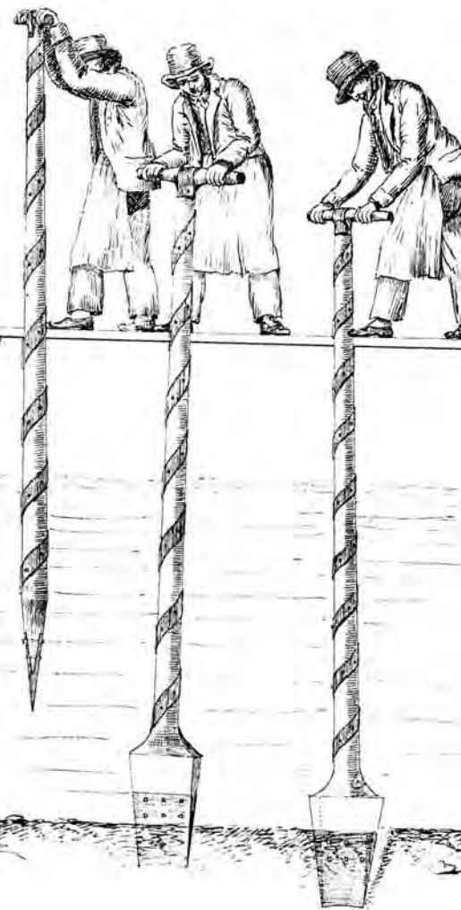
Dessin montrant l'opération dite du pilotage, soit le plantage de pieux de soutènement (Archives d'Etat de Genève)
